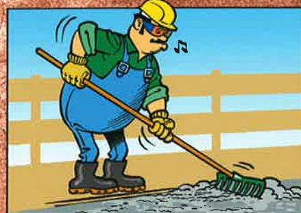
FALLS ES NOTWENDIG IST, DEN BETON ZU VERTEILEN, SIND SCHAUFEL ODER RECHEN ZU BENÜTZEN UND NICHT DIE VERDICHTUNGSGERÄTE WIE Z. B. RÜTTELFLASCHEN.
