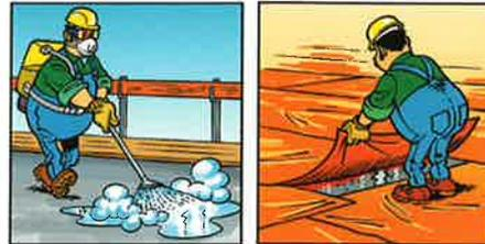
VERMEIDUNG DURCH SOFORTIGE ANWENDUNG EINES NACHBEHANDLUNGSMITTELS, AUFRECHTERHALTEN EINES WASSERFILMS ODER ABDECKEN DURCH MATTEN UND FOLIEN.
