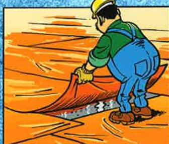
BEIM AUFBRINGEN VON MATTEN ODER FOLIEN IST AUF AUSREICHENDE ÜBERLAPPUNG ZU ACHTEN. DIE ABDECKUNG DER RÄNDER IST SICHERZUSTELLEN. AN DEN KANTEN UND STÖßEN SIND DIE ABDECKUNGEN GEGEN DURCHZUG ZU SICHERN.
