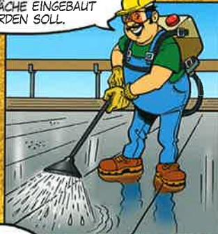
ENTFERNEN VON STAUB AUF BEREITS VORHANDENEN BETON-OBERFLÄCHEN UND FUGEN.
