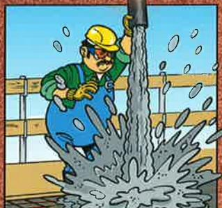
ENTMISCHUNGEN VERMEIDEN. DEN BETON NICHT MIT EINER ZU GROSSEN FALLHÖHE EINBAUEN.
